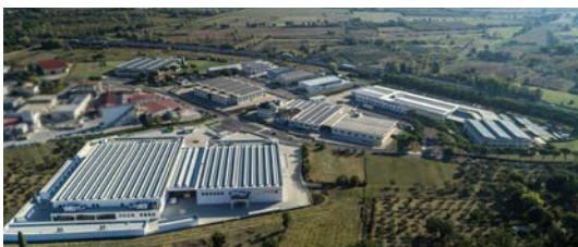
CEIA S.p.A. Headquarters, Viciomaggio, Arezzo (Italia)
