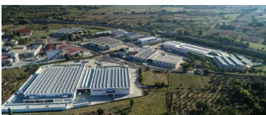
CEIA S.p.A. Headquarters, Viciomaggio, Arezzo (Italien)
