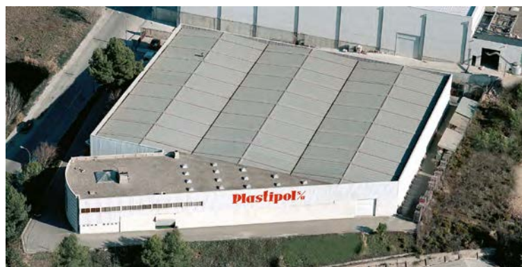
Nuestras instalaciones en Rubí (Barcelona)
