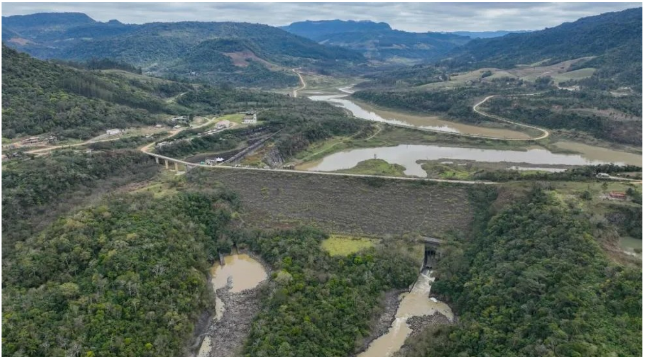
Figura 35 - Imagem aérea da barragem norte
