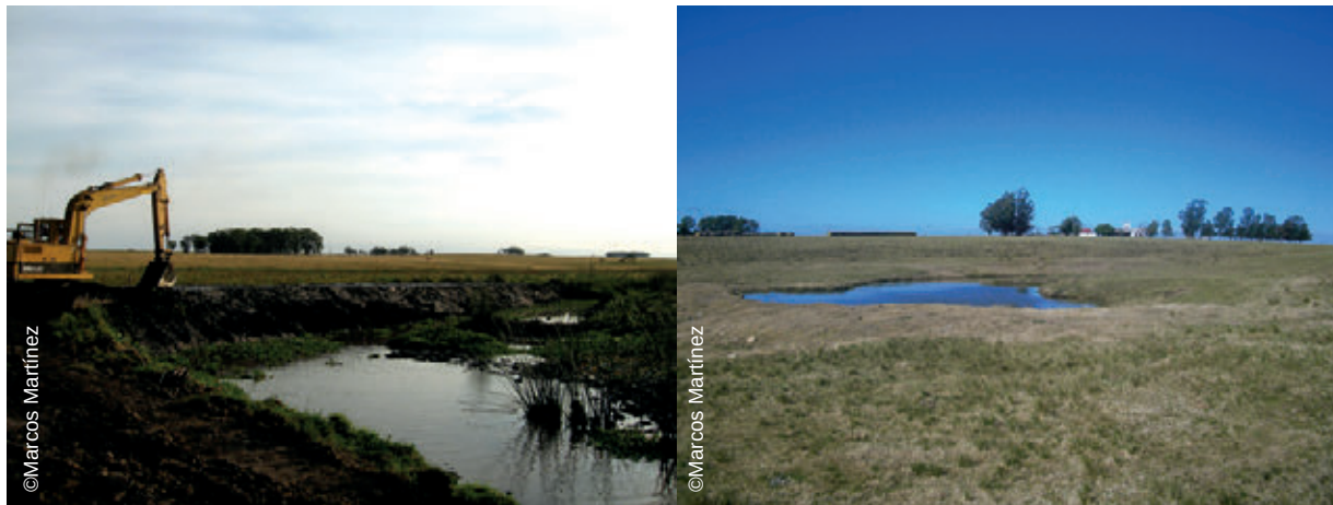
Retroexcavadora confeccionando tajamar y, a la derecha, tajamar con 4 metros de profundidad
