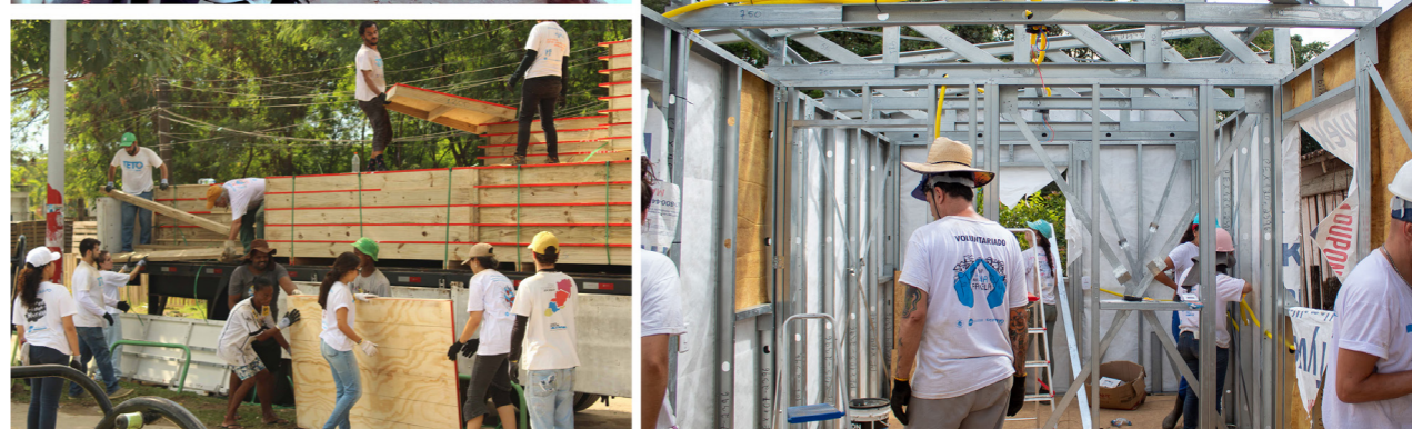
Voluntários construindo - imagens acervo TETO Brasil
