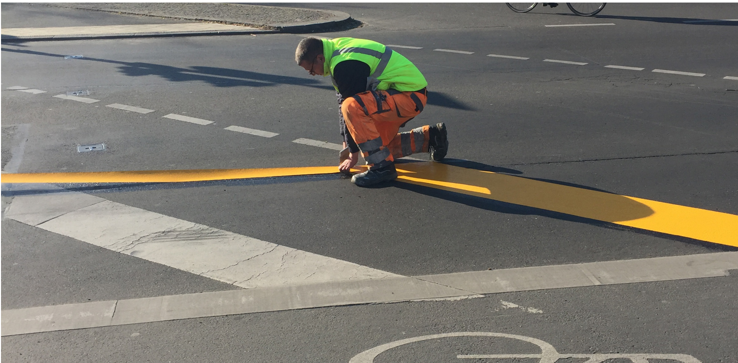
Les mesures temporaires sur Zossener Brücke (Source : Bezirksamt Friedrichshain-Kreuzberg)
