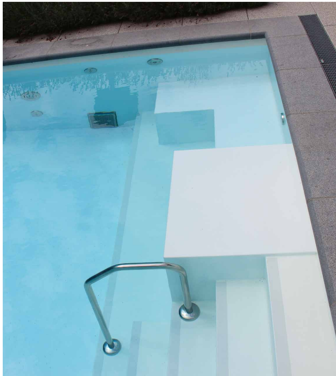
Im Einstiegsbereich mit Treppe und Startblock wurde rechts auch eine Sitzbank mit Massagedüsen eingebaut.
